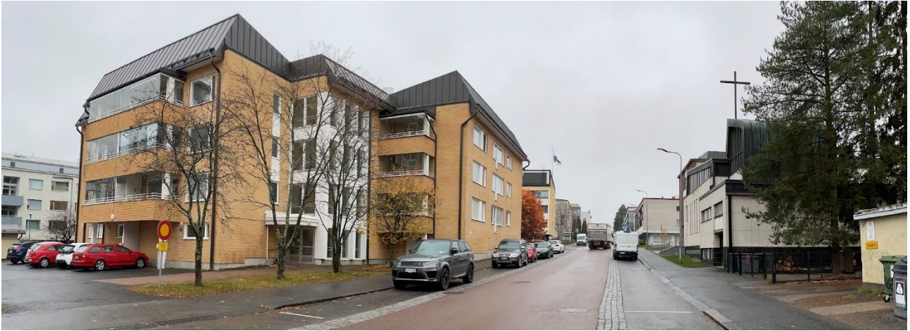
Kuvassa Yrjönkatu 27 -rakennus joka on Yrjönkadun varressa suunnittelualueita vastapäätä. Rakennuksen itäpäädyssä on neljä maanpäällistä kerrosta ja lisäksi konttikatto. (10/2025)
